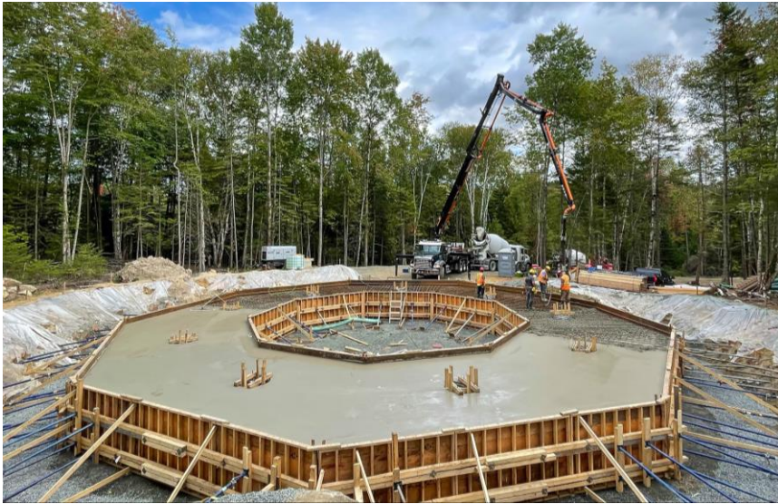
Le coulage des fondations de la tour
